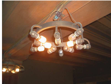
Applique conçue par I. De Rudder pour la salle des mariages, Photo 2007.
