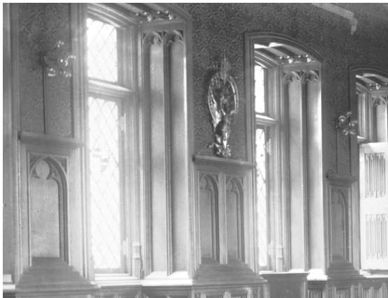
Salle des mariages. Détail du murs vers la cour lors de la pose des appliques actuelles. Certains appliques anciennes sont encore présentes, s.d. (ca 1896), AVB FI F 638.
